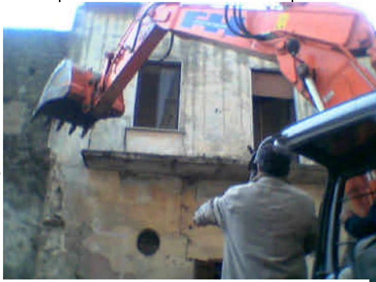
20 Ottobre 2003 - ore 8: Il Sindaco Alberico Villani guida l'inizio della demolizione del comparto di via Capone
